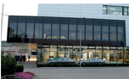
Im Erdgeschoss und 1. Stock das Experience Center, das Aufbereitungszentrum oben.
