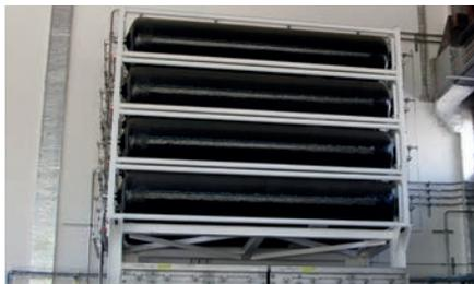
Nach der Elektrolyse wird der Wasserstoff gasförmig in grossen Flaschen gespeichert.
