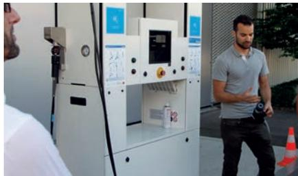
Projektmanager Urs Cabalzar erklärt den Tankvorgang eines Wasserstoff-Fahrzeuges mit Brennstoffzelle: Der Tankvorgang ist in etwa 3 Minuten vollzogen und dem Betanken eines Erdgasfahrzeuges sehr ähnlich.
