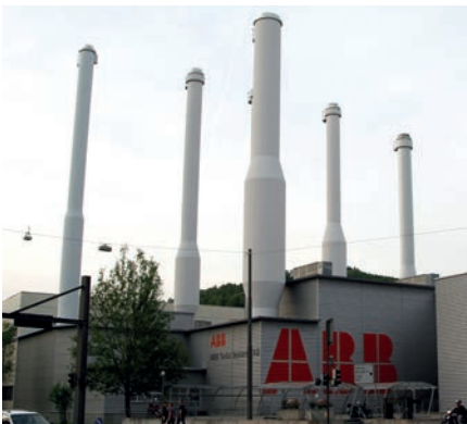
Das Test Center der Turbo Systems AG verfügt über grosse Prüfstände, deren Abgaskamine markant in den Himmel ragen.
